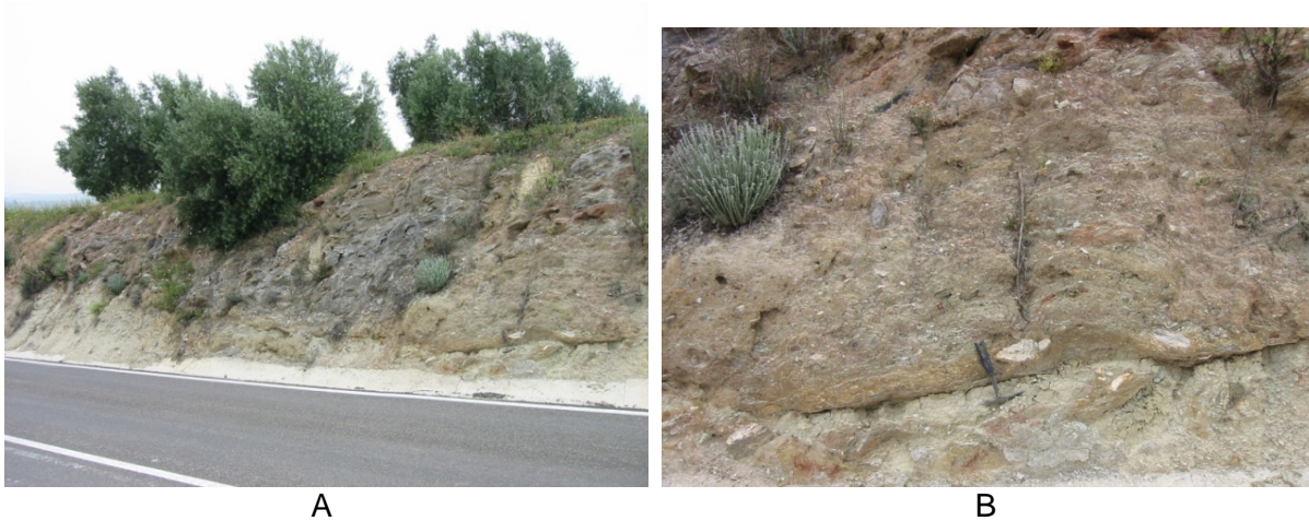
Foto 2-11.- En el talud de la carretera: en la parte baja, tectonosoma de unidades cretácicas, sobre éste la Unidad Olistostrómica. B: detalle de la A
