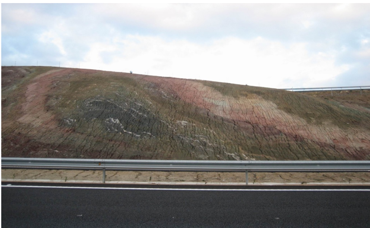
Foto 2-5. Repliegues de la Unidad Olistóstromica que se han interpretado como formados a partir de la tectónica posterior al Serravalliense inferior.
